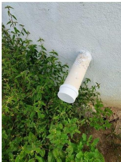
Detalhe do tubo extravasor com tampão, porém lacrado. Fazer furinhos para permitir a vazão de água.
