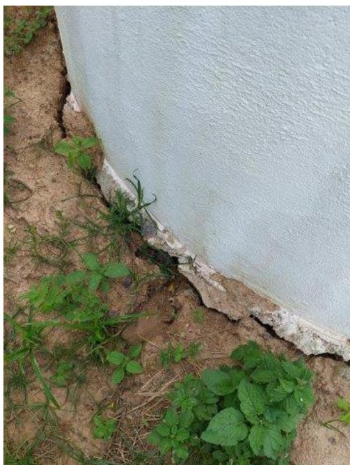
Fotos 17 e 18 mostram a deterioração externa na base da cisterna, podendo ocasionar danos mais sérios. Os proprietários precisam ser fortemente conscientizados da importância da sua conservação e manutenção.
