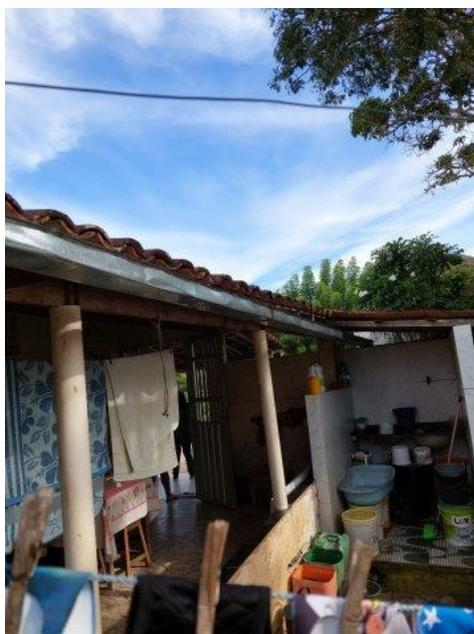
Fotos 12 a 16 mostram um sistema muito bem instalado. A calha larga, bem colocada e ajustada ao telhado; a tubulação bem encaixada à saída da calha; instalação perfeita e com excelente aproveitamento.
