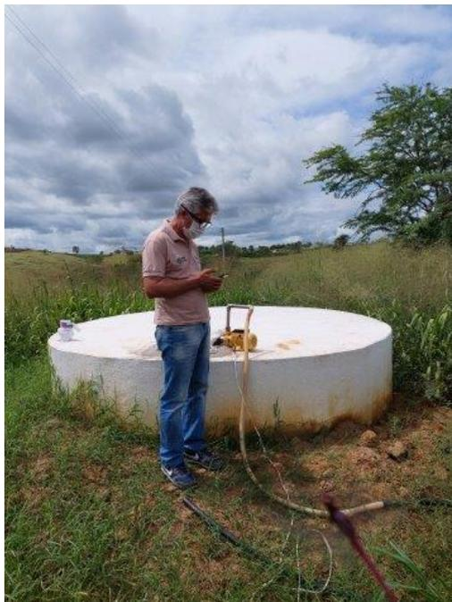
Mostra a bomba instalada pelo(a) associado(a), fora da cisterna; aqui a sugestão seria fazer um pequeno abrigo para a bomba não ficar sujeita a intempéries, e não precisar ser retirada e reinstalada.
