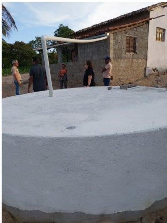
Instalação funcionando perfeitamente. Inclusive o telhado muito apropriado, com duas águas convergindo para a calha, torna o aproveitamento excelente.
