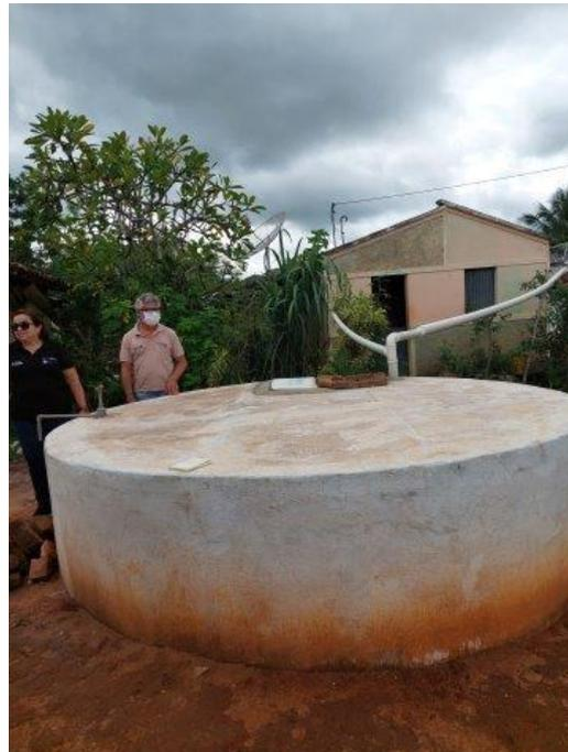
Fotos 06 e 07 mostram a adição de captação de água feita pelo(a) associado(a), de forma adequada: melhora significativa no volume captado.
